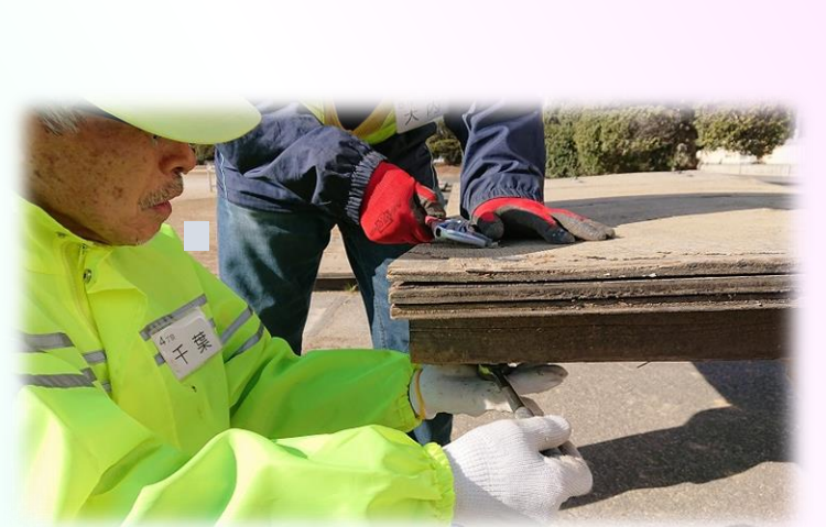
同時に老朽化した縄跳び台 の解体をする
