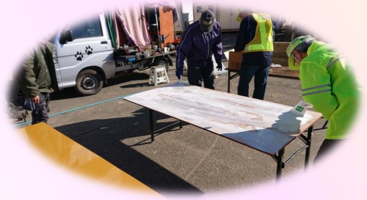
コンパネ板の裏にボンドをつけて、2枚を貼り付ける作業
