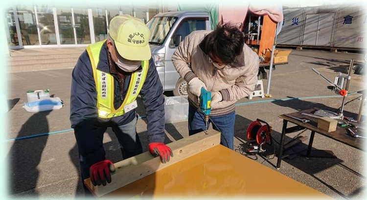
土台の足の下穴をガイドとして コンパネにも穴をあけて、その穴 にボルトを通して固定
