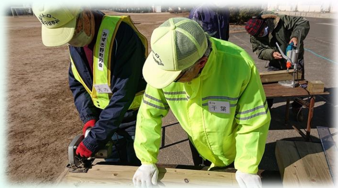
コンパネ板を固定する足の寸法切り
