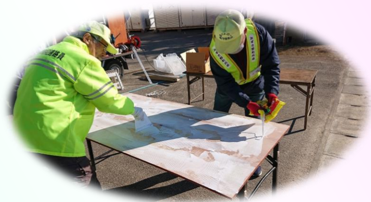
コンパネ板の裏にボンドをつけて、2枚を貼り付ける作業
