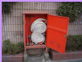
消火栓格納箱の点検
